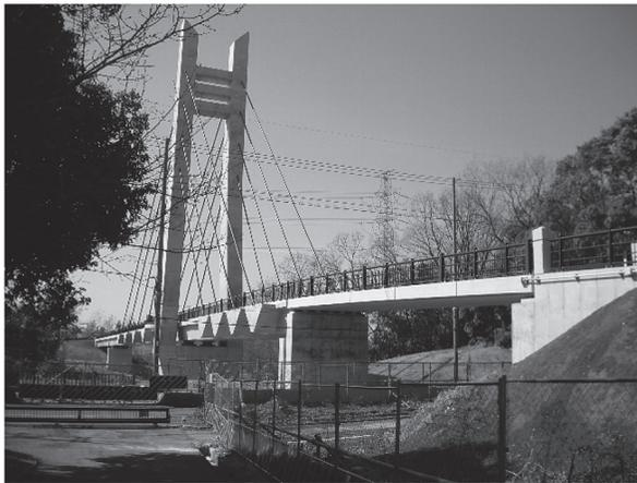
写真 - 2 山田池公園橋梁（手前の径間が高強度 PC 鋼材を用いたプレテンション方式単純中空床版橋）
