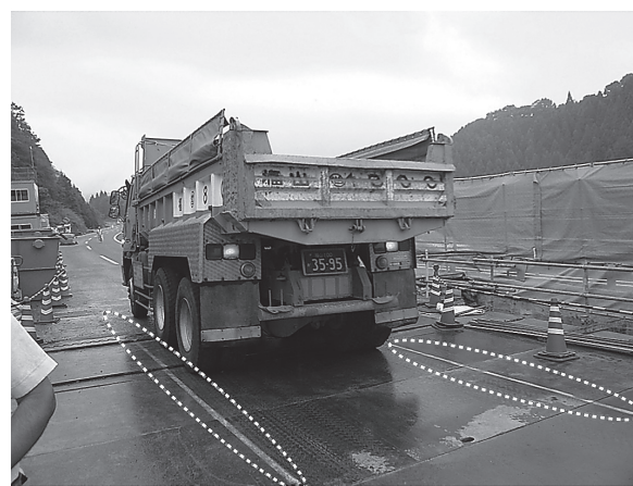
写真 - 6 主桁位置の明示
