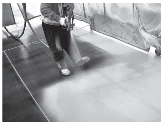
写真 - 15 ウレタン系防水施工状況
