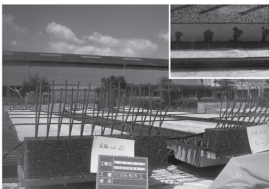
写真 - 4 散水養生状況
