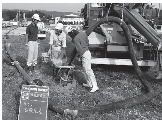
写真 - 10 圧送試験状況
