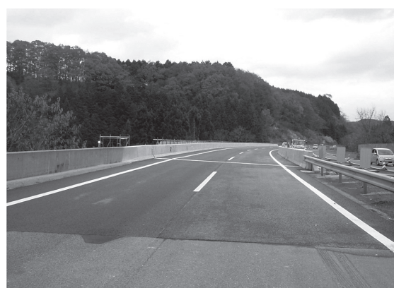
写真 - 16 完成状況 (橋面から)
