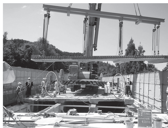
写真 - 8 アウトリガー張出し状況 (PC 床版架設時)
