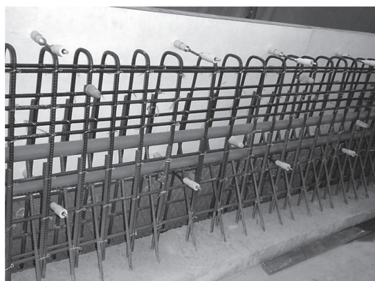
写真 - 13 型枠設置状況
