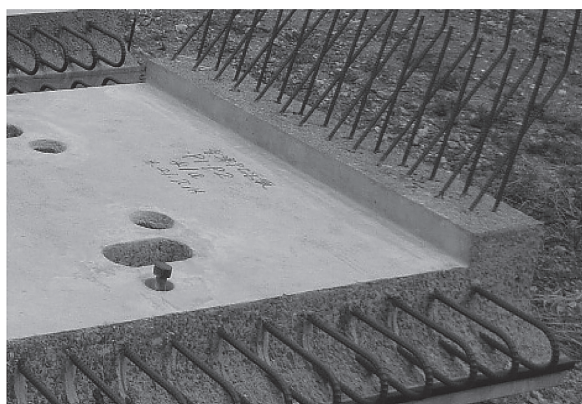
写真 - 3 地覆の一体製作状況
