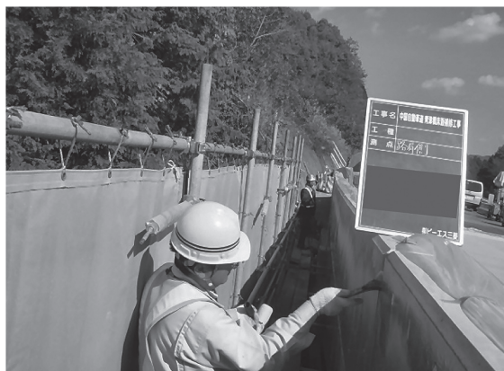
写真 - 11 含浸材塗布状況 (壁高欄)
