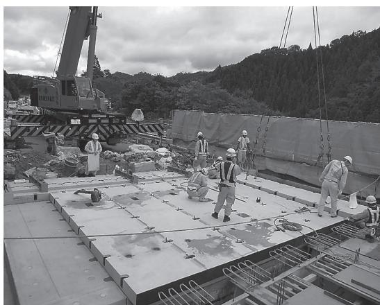
写真 - 9 延長床版施工状況
