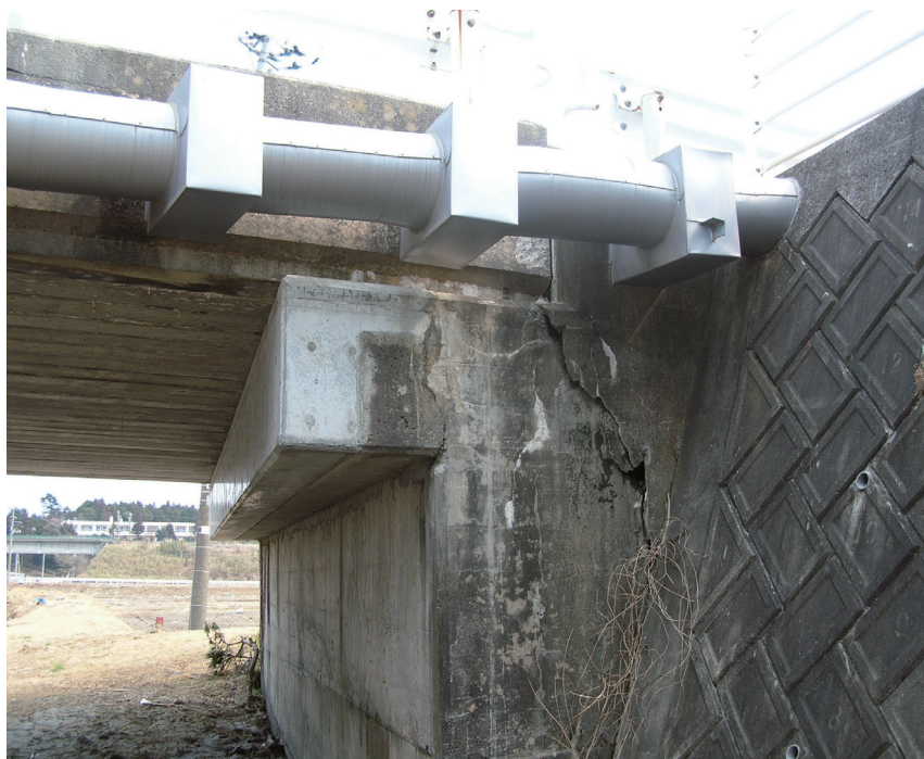
地震動による伸縮装置および橋台の損傷
