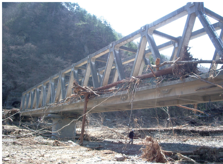
津波を被った三陸沿岸部の PC トラス橋
