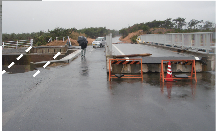
千葉県沿岸部での津波による PC 桁の移動
