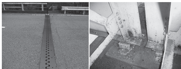
(a) 鋼製伸縮装置
