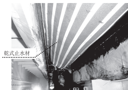
写真 - 7 補修施工状況
