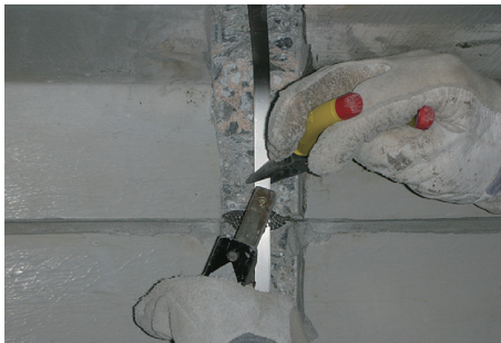
写真 - 9 コンダクターバー設置状況
