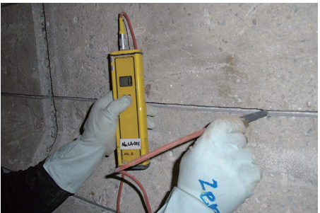
写真 - 10 溝内部の金属探査状況
