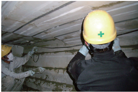
写真 - 8 陽極（チタンリボンメッシュ）設置状況
