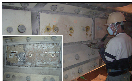
写真 - 6 亜鉛シート撤去状況
