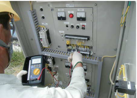
写真 - 12 通電調整状況
