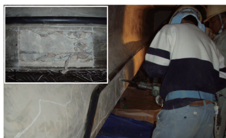
写真 - 5 オーバーレイモルタルはつり状況
