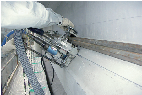
写真 - 7 溝切状況
