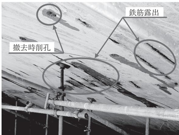
写真 - 1 既設RCドーム屋根内面
