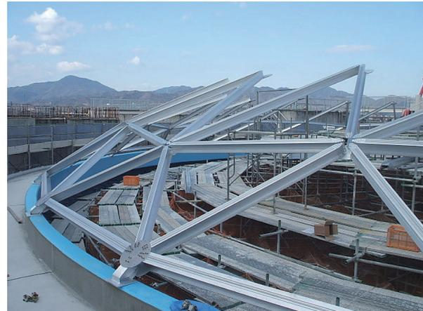
写真-5 設置位置での直接組立て(1)
