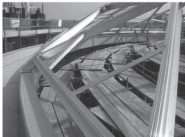
写真 - 8 ストラットのブレース結合
