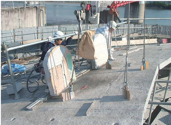
写真-4 吊金具による切断・吊出し
