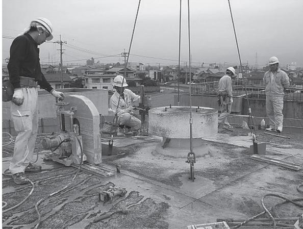
写真-2 ウォールソー工法による切断
