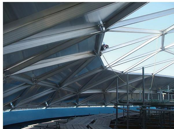
写真-6 設置位置での直接組立て(2)
