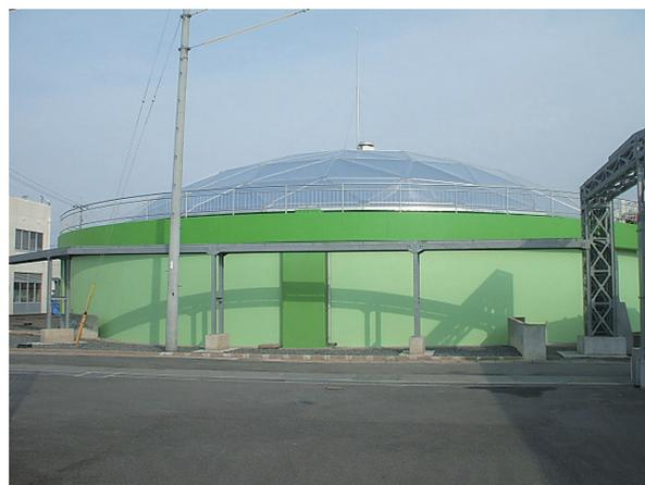
写真 - 10 アルミドーム屋根架替完成
