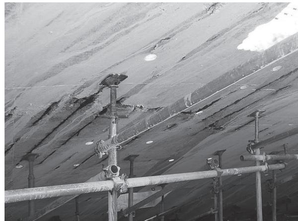
写真-3 既設RCドーム屋根解体時の支持
