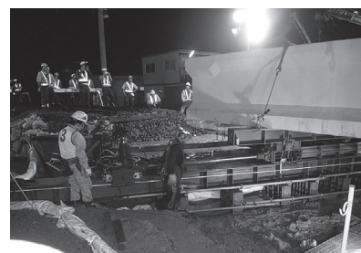
写真 - 6 桁横取り架設状況
