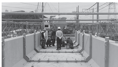
写真 - 4 打設状況
