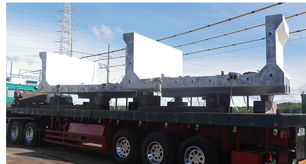
写真-3 プレキャストブロック運搬状況
