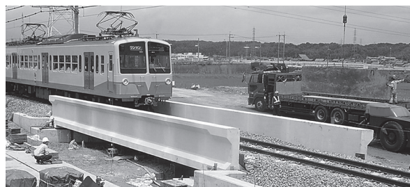
写真 - 1 完成状況
