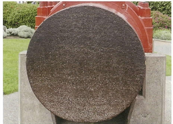
写真 - 12 Golden Gate 橋主ケーブル
