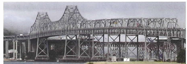
写真 - 14 San Francisco-Oakland Bay 橋（トラス）
