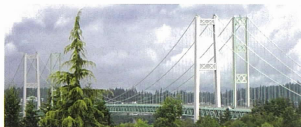
写真 - 17 Tacoma Narrows 橋
