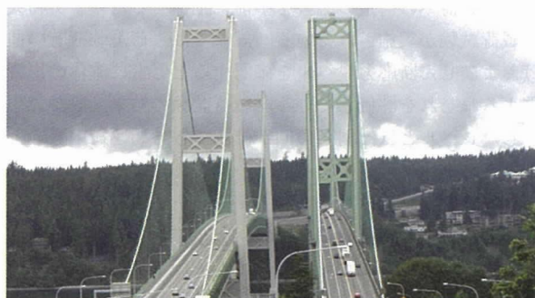
写真 - 18 Tacoma Narrows 橋（左が新橋）
