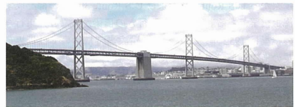
写真 - 13 San Francisco-Oakland Bay 橋（吊橋）
