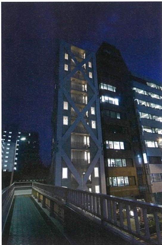
写真 - 13 立体トラスの夜景
