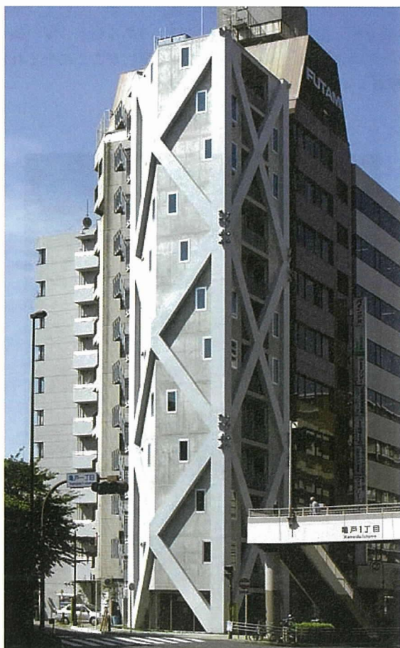
写真 - 1 建物全景
