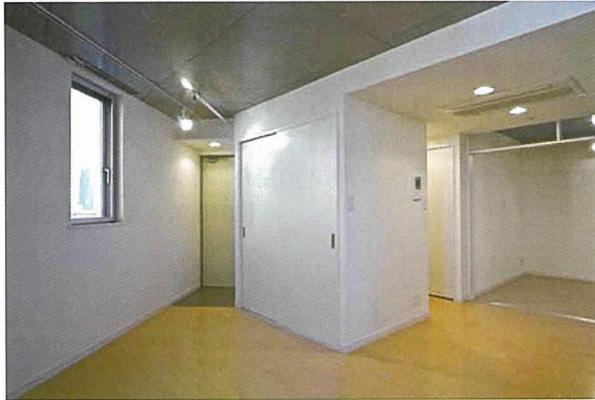
写真 - 11 梁・柱が出ない内部空間が実現
