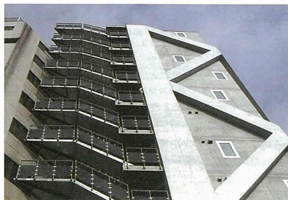
写真 - 2 三角形部分の鉄骨階段
