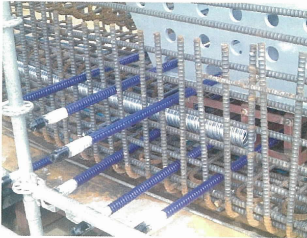
写真 - 2 プレグラウト鋼材の使用
