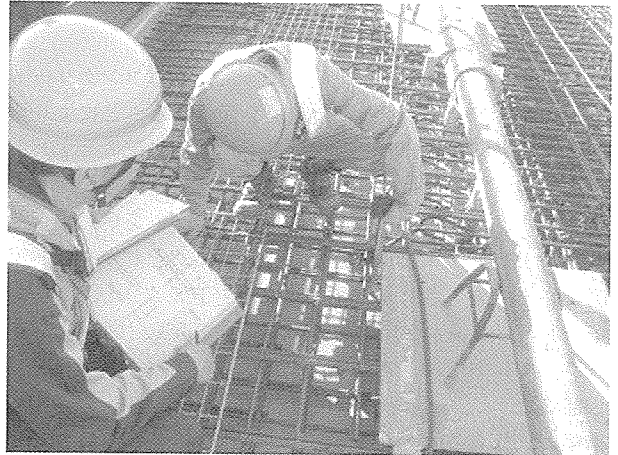
写真-8 毎回確認状況（代表箇所測定）
