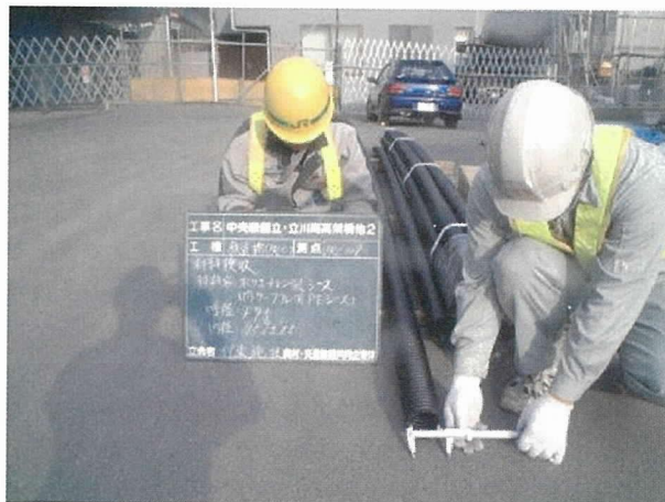
写真 - 4 プラスチック製シースの使用
