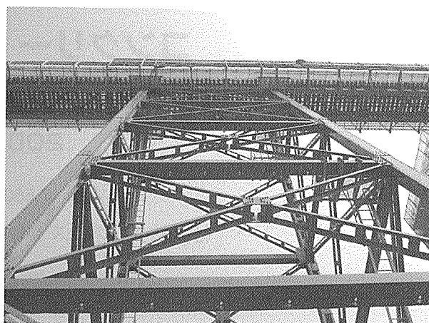
写真-5 余部鉄橋（下方より）
