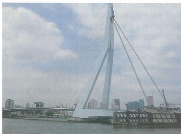
写真 - 4 エラスムス橋
