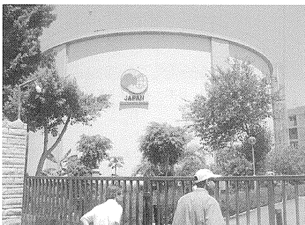
写真-10 PC水タンク
