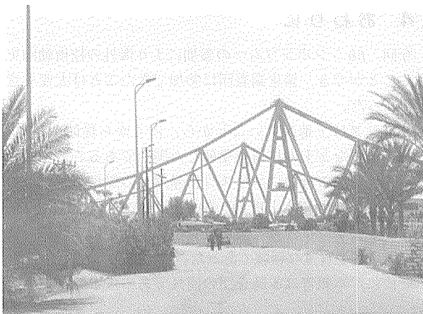
写真 - 8 フェルダン鉄道橋
