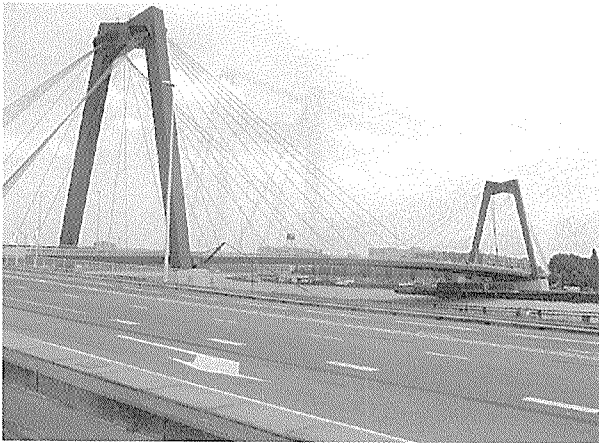
写真-5 ウイレムス橋
