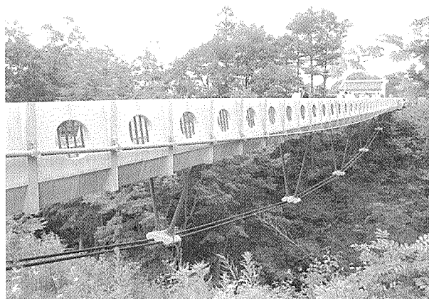
写真-1 青春橋（中学校側より）
