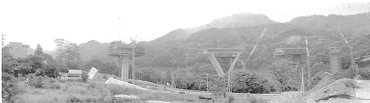
写真 - 5 長野原 3 号橋全景
