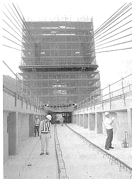
写真-11 第二吾妻川橋梁（橋面上）
