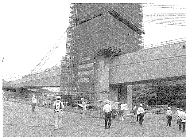
写真-9 第二吾妻川橋梁見学状況（P2）
