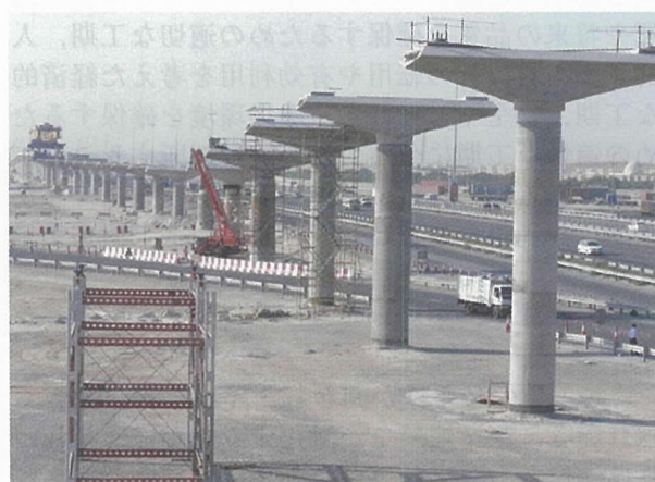
写真-2 高架橋橋脚
