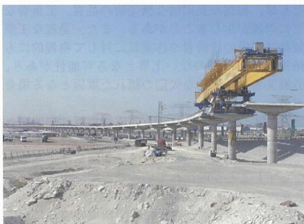
写真-1 スパンバイスパン工法による高架橋建設
