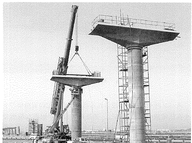
写真-9 プレキャスト型枠の設置
