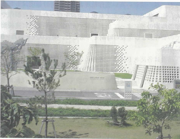
写真-6 PCaPC 外壁版架設完了後
