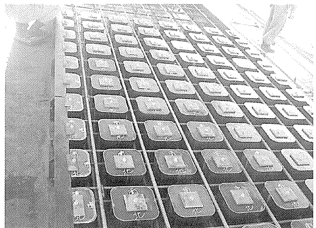
写真-4 抜き型枠セット状況
