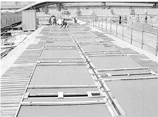
写真-10 サイトプレキャストスラブ製作状況
