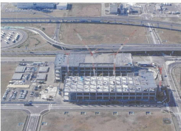
写真 - 16 施工状況全景 (20 m スパン施工前)
