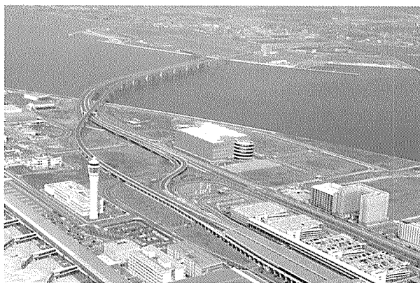
写真-1 建物周辺状況
