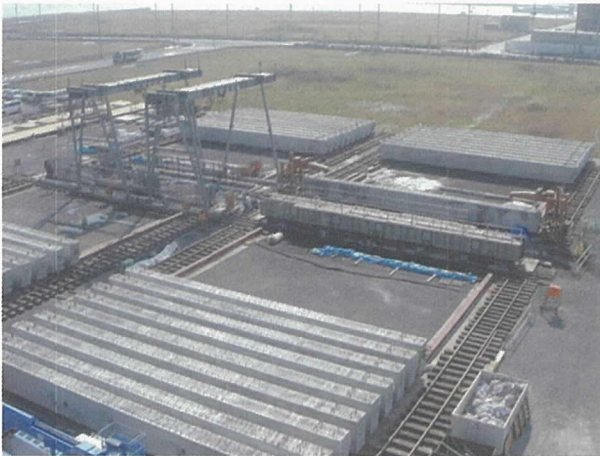
写真 - 14 サイトプレキャスト製作ヤード
