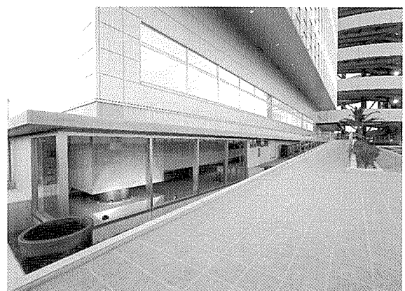
写真-4 免震ギャラリー外観
