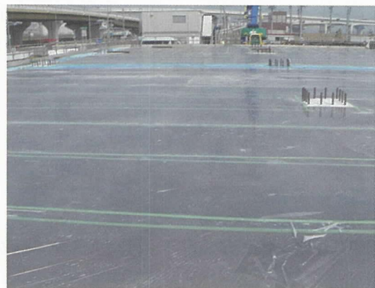
写真 - 18 コンクリート打設後の養生状況
