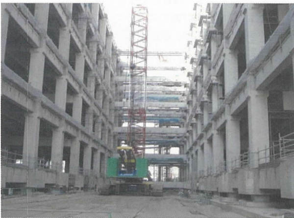
写真 - 15 架設・施工状況
