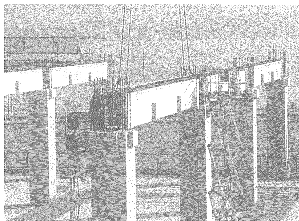
写真 - 6 プレキャスト大梁架設状況
