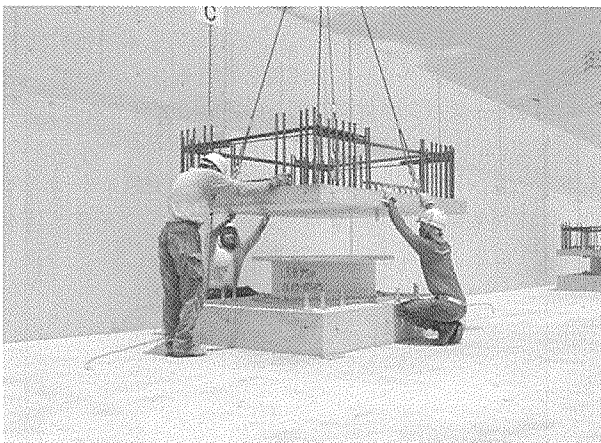
写真-9 免震装置上部基礎施工状況
