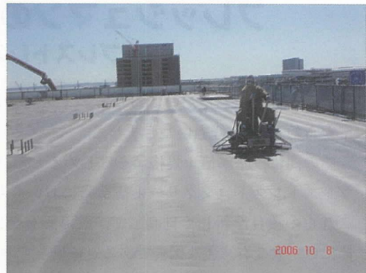
写真 - 17 スラブコンクリート打設状況
