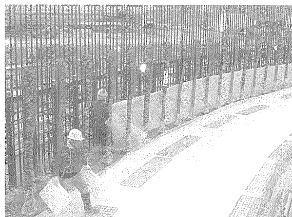
写真-3 基礎版空気膜養生
