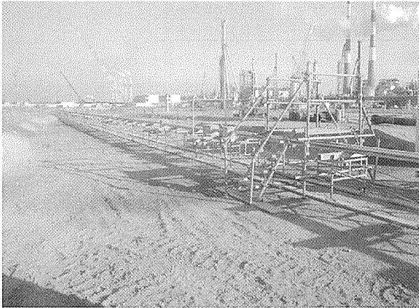
写真-4 長大水平グラウト実大試験体
