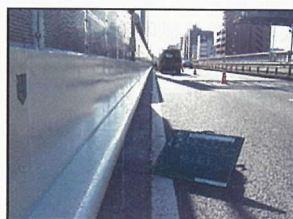
断面修復+表面被覆
