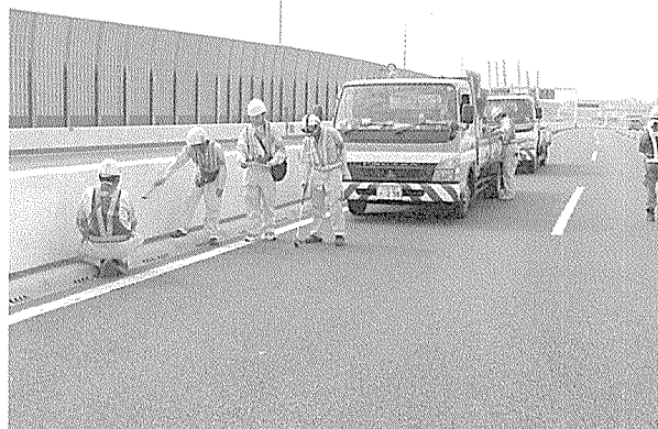
写真-2 高速道路上徒歩点検実施状況
