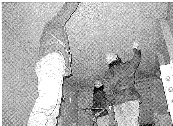
写真-4 RC床版の接近点検実施状況
