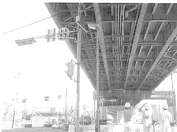
写真-3 高架下徒歩点検実施状況
