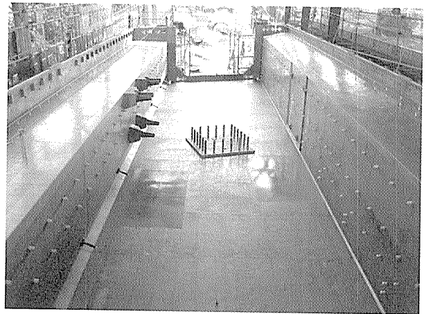
写真 - 5 外型枠組立て状況
