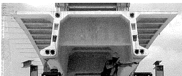
写真 - 16 仙遊橋の \pi 形断面
