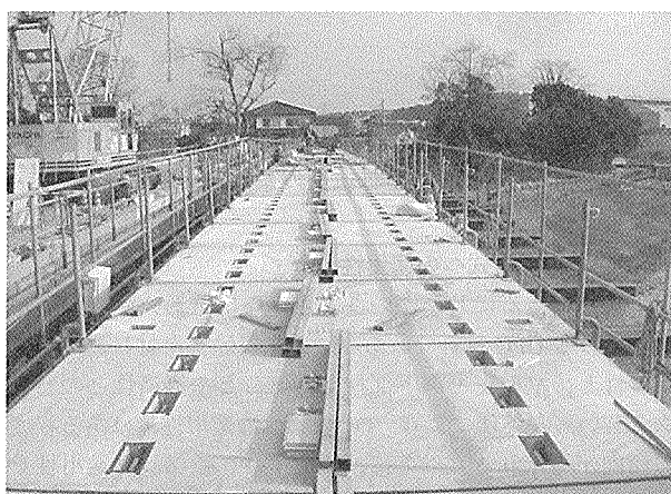
写真-18 三兼池橋 床版設置状況
