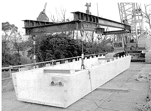
写真-17 三兼池橋 プレキャストブロック (幅 2.1 m, 長さ 10.5 m, 重量 9.2 t)
