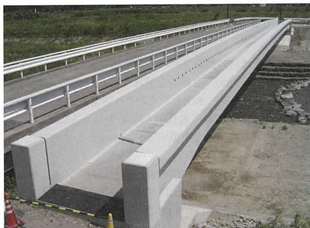
写真-6 曳田歩道橋
