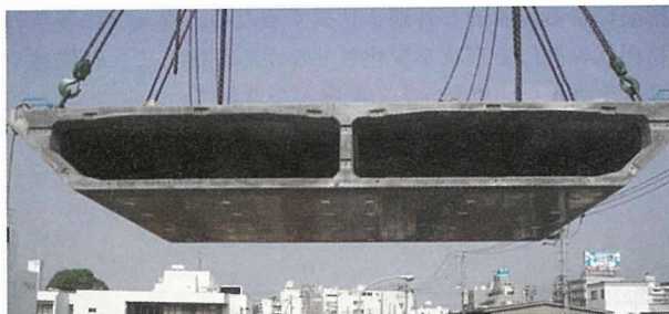
写真-5 豊田市横断歩道橋 断面写真
