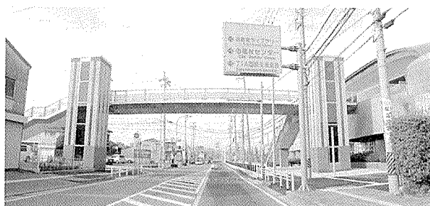
写真 - 4 豊田市総合体育館横断歩道橋（仮称）
