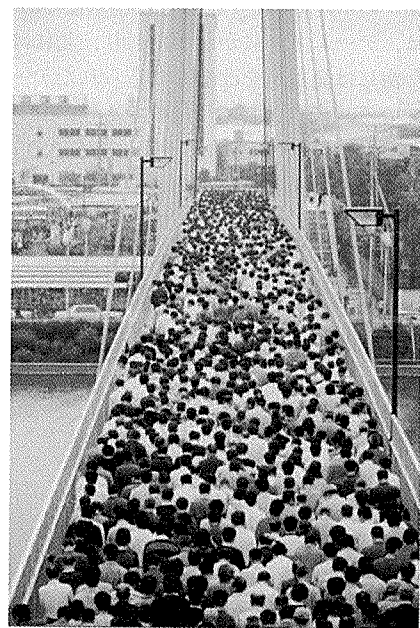
写真 - 3 群集の通過の中で横揺れする橋
