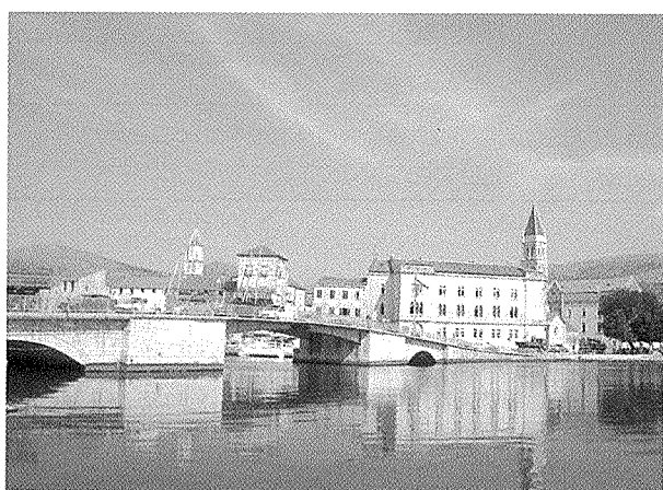
写真 - 18 Ciovo の跳開橋 全景
