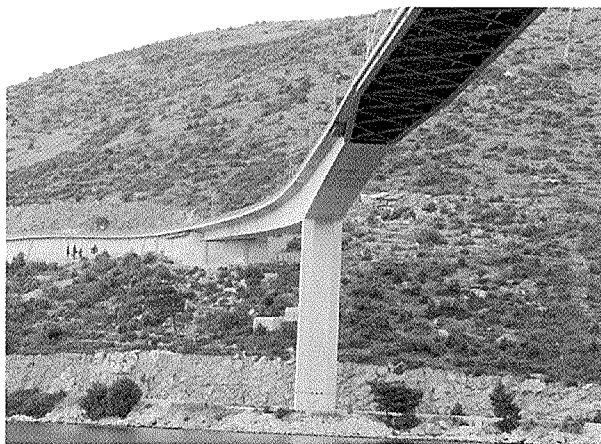
写真 - 12 Dubrovnik 橋 桁下面
