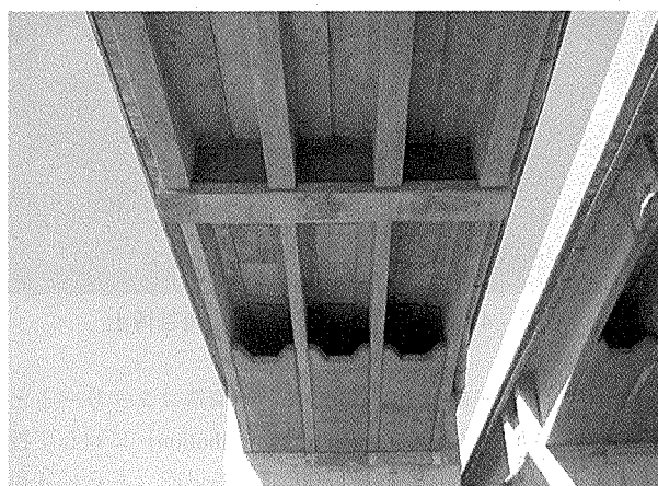
写真 - 7 Dreznik 高架橋 河川部（桁下面）
