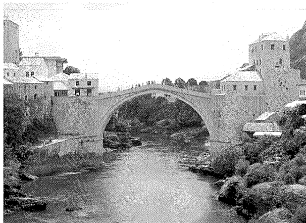
写真 - 13 Mostar 橋 全景
