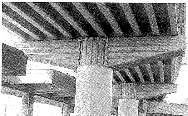
写真-7 電気防食工完成（手前 P4 橋脚，奥 P5 橋脚）
