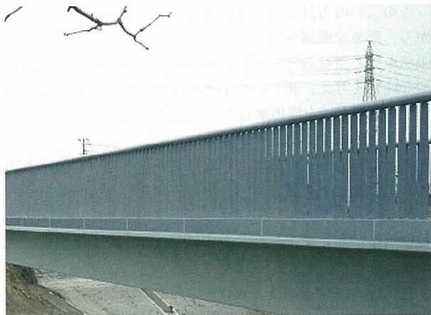
写真 - 3 ステンレス製の地覆カバーとアルミ鋳物高欄
