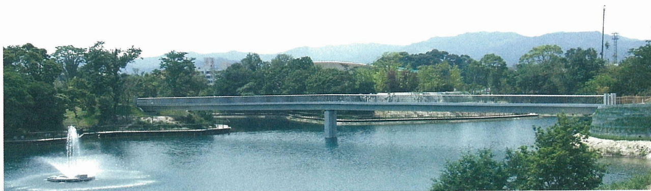
写真 - 6 完成後の橋梁全景
