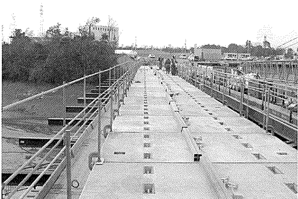
写真-15 床版設置後 (開口部からジベルが確認できる)
