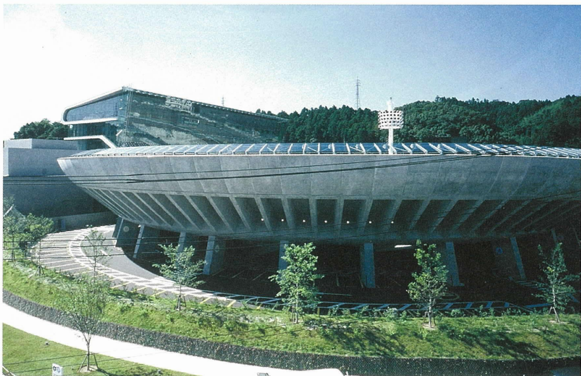
写真-2 競輪走行路の曲線(新マコンネル曲線)を表現するバンク側面
