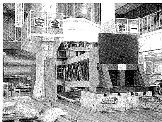
写真-5 終局載荷実験状況
