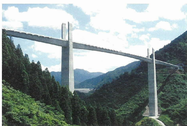
写真 - 1 徳之山八徳橋の全景
