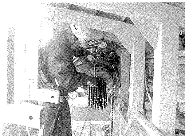
写真-8 緊張作業状況
