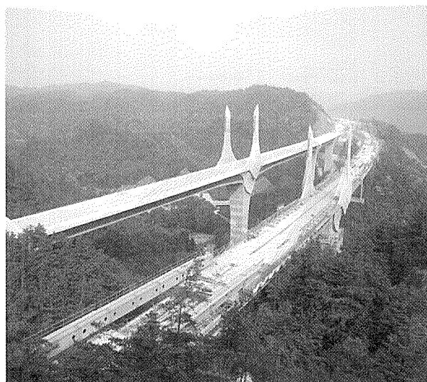
写真 - 1 栗東橋全景
