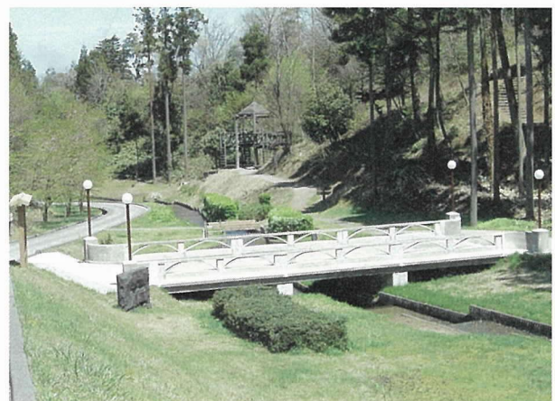
写真-8 移設後の長生橋（2003年4月撮影）
