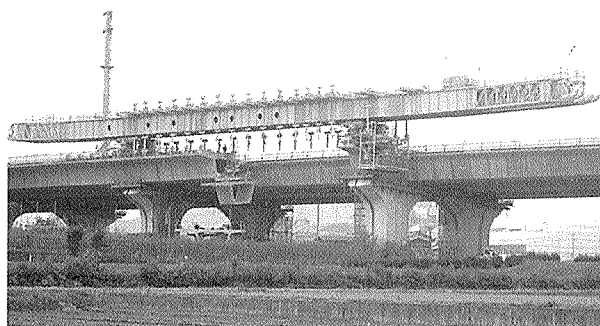
写真-2 スパン・バイ・スパン工法（ハンガータイプ）
