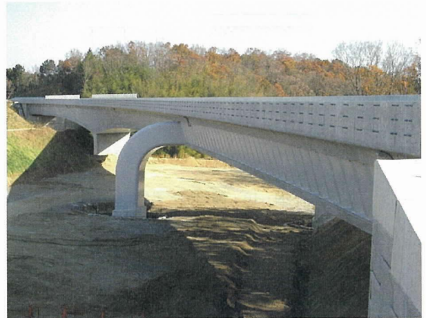
写真-4 C ランプ第二橋の完成
