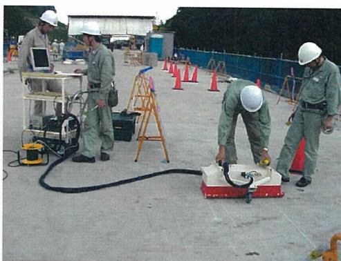
図 - 19 朝比奈川橋での探査状況
