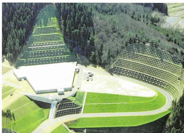
写真-4 完成写真（上空より調整槽を望む）
