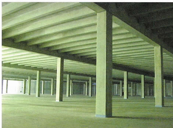
写真-5 完成写真（調整槽内部）
