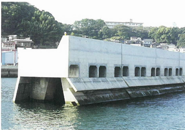
写真 - 1 PC 二重カーテン式消波
