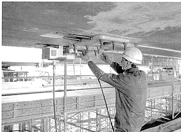
写真 - 6 緊張作業
