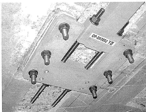
写真 - 5 緊張前の定着装置
