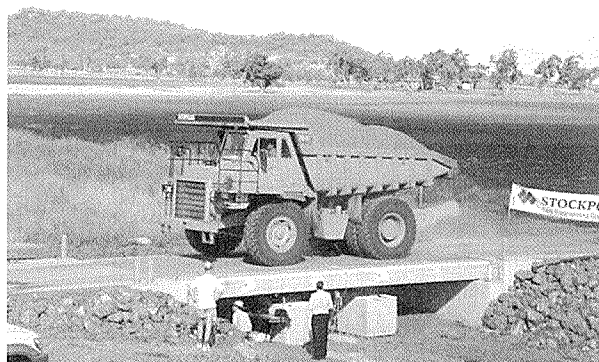
Fig. 11 (写真 - 11) - Australia's First Fibre Composite Bridge Built in Toowoomba (Toowoomba に架設されたオーストラリア初の繊維複合橋)
