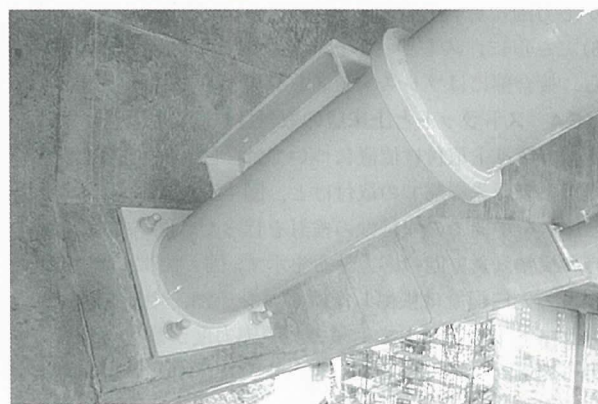
写真 - 1 ストラットの防錆（ウェブ接合部）
