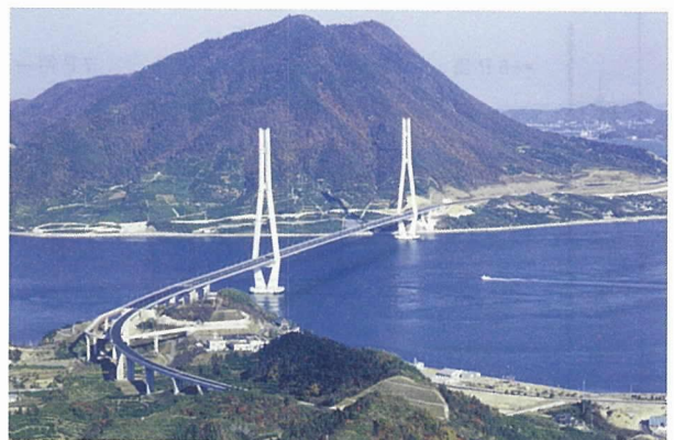
写真 - 2 多々羅大橋
