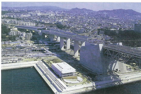
写真 - 1 舞子高架橋
