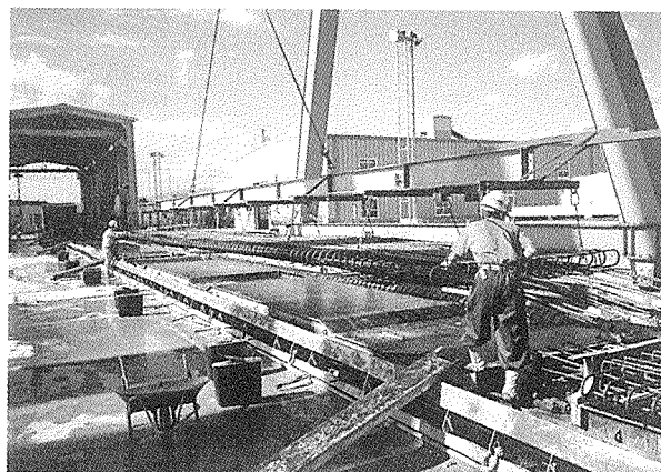
写真-5 鉄筋吊り治具
