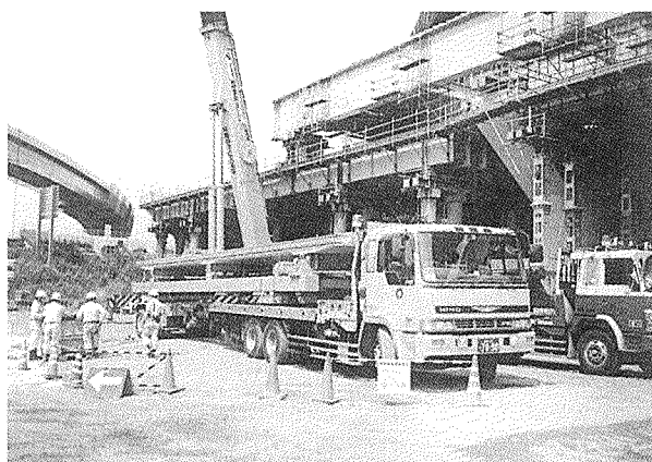
写真 - 11 PC床版運搬状況
