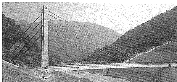
写真-3 松ヶ山橋
