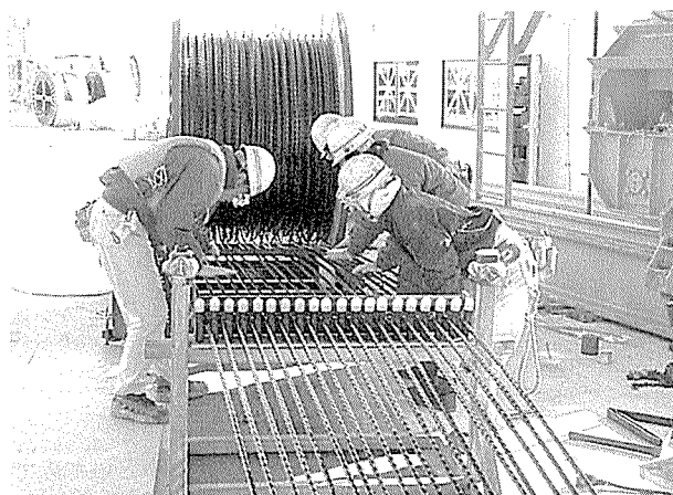
写真-3 防錆ケーブルの検査状況
