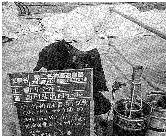
写真-6 グラウト排出口での流下試験
