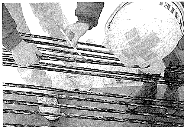
写真-3 防錆ケーブルの検査状況
