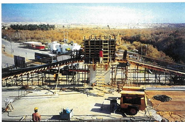
写真-3 主塔施工状況
