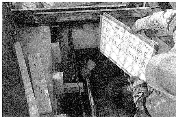
写真-5 シングルストランドジャッキによる緊張状況
