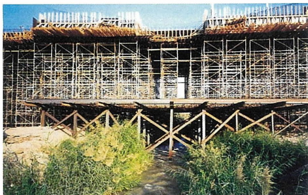
写真-2 主桁支保工状況
