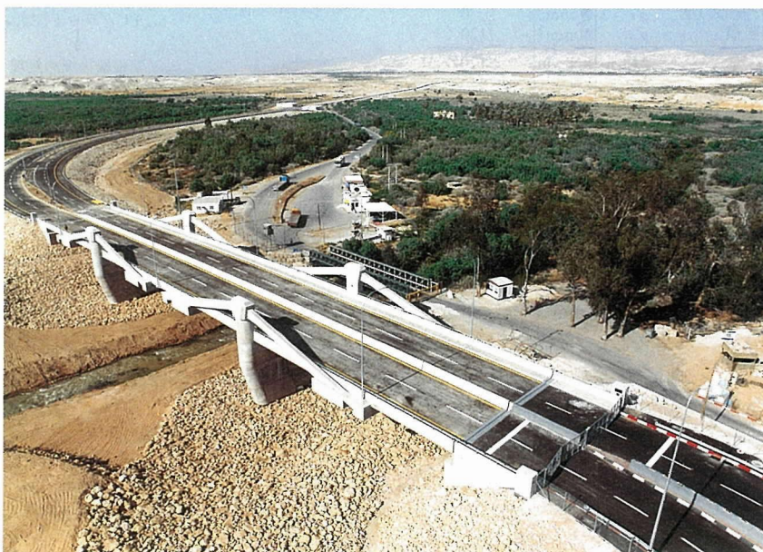
写真 - 1 完成したキングフセイン橋
