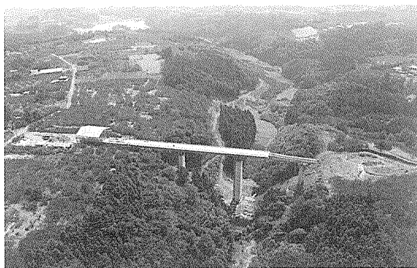
写真-1 全景（施工時）
