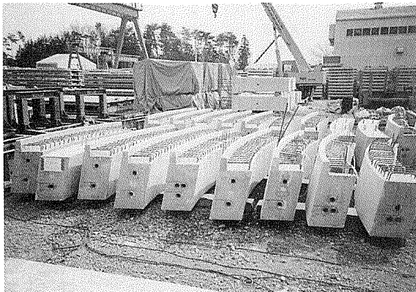
写真-3 外周梁のストック状況
