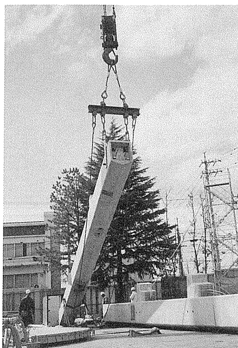
写真-4 外周柱の吊上げ状況
