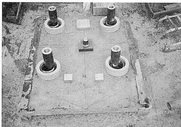
写真-5 外周柱・基礎天端状況
