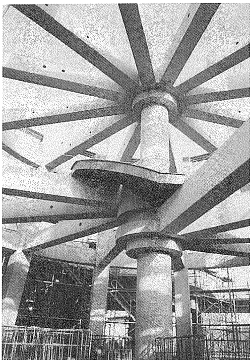
写真-8 架設完了後
