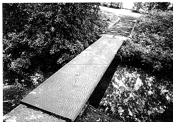
写真-1 武蔵大学の歩道用渡り橋 （プレテンション板）
