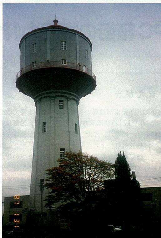
写真-13 大正14年に建造された高架水槽
