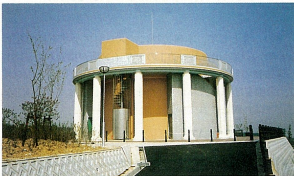
写真-5 公園展望台の機能をもつPCタンク
