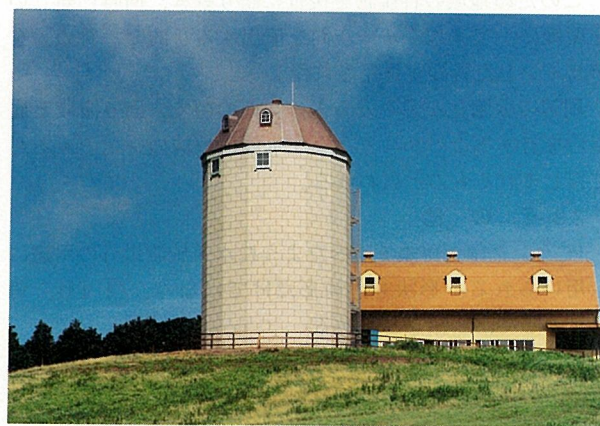
写真-7 サイロをデザインしたPCタンク
