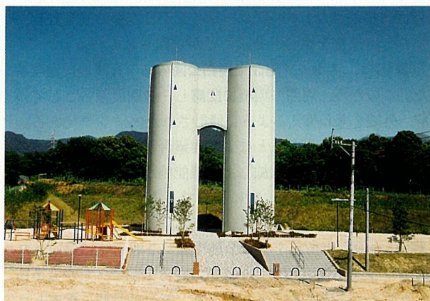
写真-9 頂部を連結したツインPCタンク
