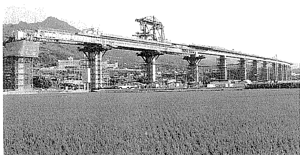
写真-6 プレキャストセグメント工法の施工状況
