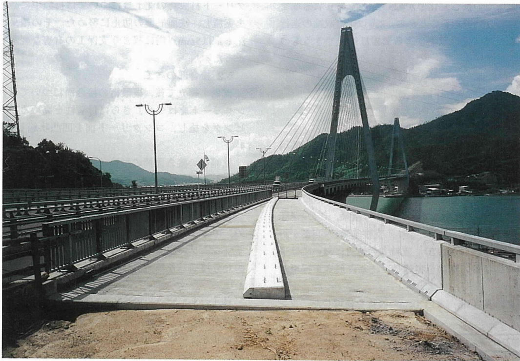
写真-6 完成状況
