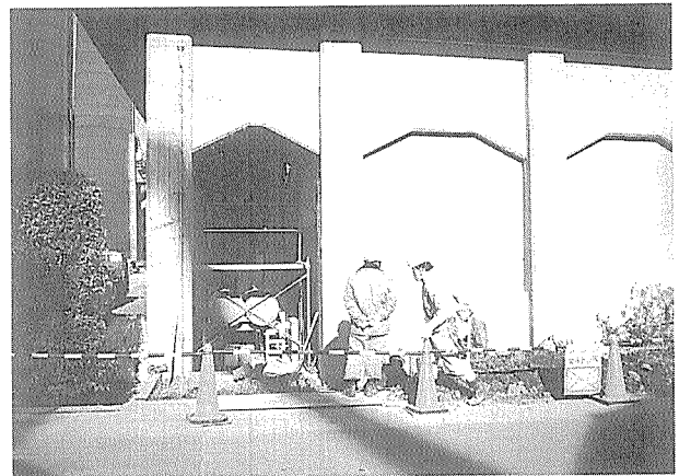
写真-1 補強前の状況
