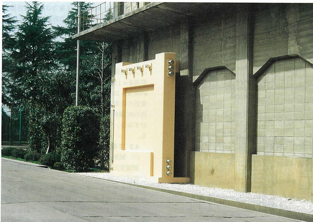
写真-5 補強後の状況
