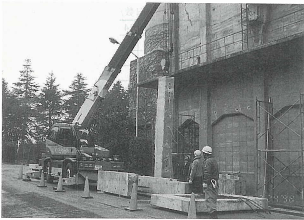
写真-3 組立て状況
