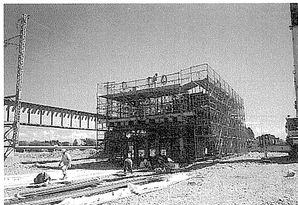
写真一 桁式支保工による柱頭部の施工状況 (P3)
