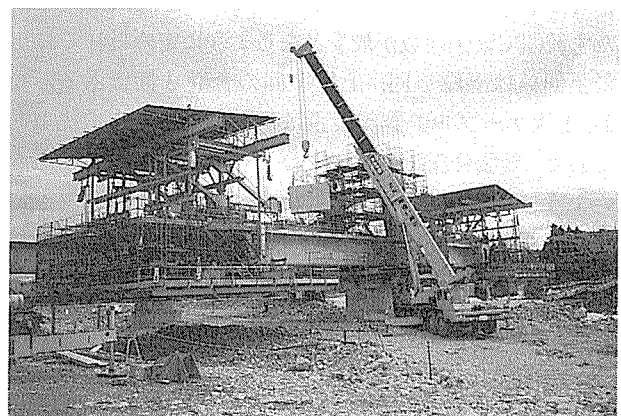
写真-3 クレーンによる主塔ブロックの架設状況
